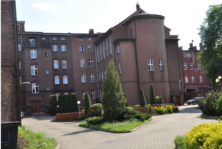
Bild: Ansicht des Klosters vom Innenhof aus
